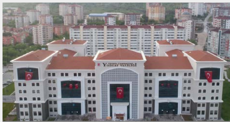
YOZGAT HÜKÜMET KONAĞI
