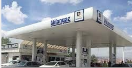
MİLANGAZ KÖRFEZ LPG TERMINALİ- (KOCAELİ)
