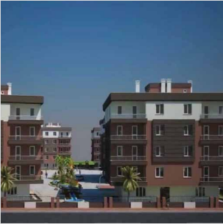
Topal Park Konutları | Antalya IP Apartman Konuşma Sistemi 7 Blok, 121 Daire
